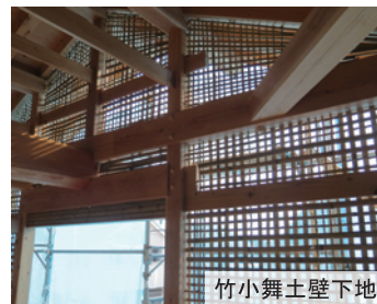
手刻みによる部材仕口継手
