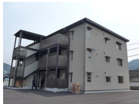
CLT勝山共同住宅
