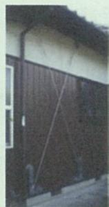
(参考)一般的な工法である「①筋かいで補強」とのコスト比較
